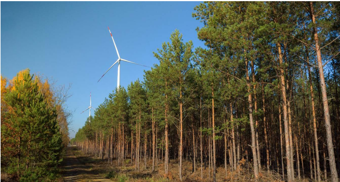
Abbildung 1: Windenergieanlagen im Kiefernforst
