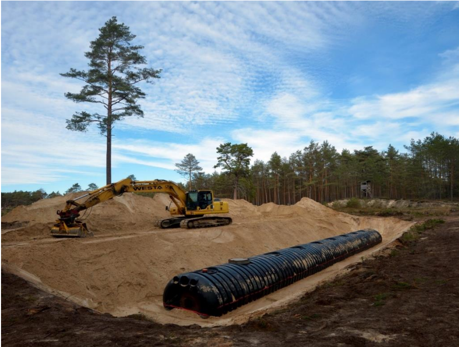
Errichtung einer Löschwasserzisterne am Waldbrandriegel im Forstamt Kaliß (Foto: THOR, 2022)
